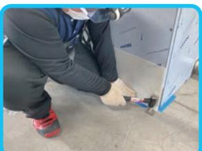
支持金具による固定や、あと施工アンカーの打設を行います。該当工事をご希望の場合は、先行して下地の仕様、アンカー種類等をお知らせください。
