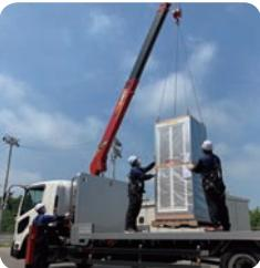
組立済みのシャワーブース等を荷下ろし可能な車両で搬送し、場内移動も行います。完成状態で搬入できない場合は、製品を分割して搬送します。
