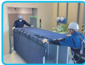
組立済みのシャワーブース等を荷下ろし可能な車両で搬送し、場内移動も行います。完成状態で搬入できない場合は、製品を分割して搬送します。
