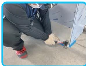
支持金具による固定や、あと施工アンカーの打設を行います。該当工事をご希望の場合は、先行して下地の仕様、アンカー種類等をお知らせください。
